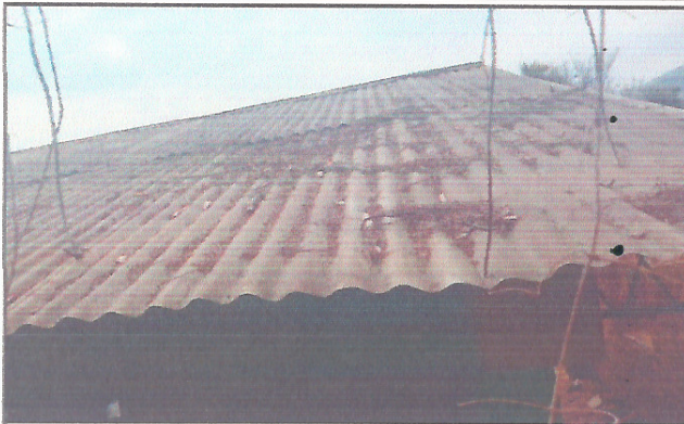
Foto 1: MEJORAMIENTO DE ESTRUCTURA DE TECHO TIPO PORTICO
